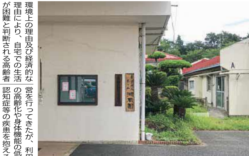
利用者への配慮と安全性を確保した再整備を行う＝湘風園本館
